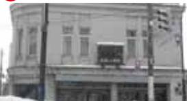
大正10年(1921)の大火後に建てられた木骨コンクリート造りの建物は、昭和9年(1934)の大火により焼失。その直後に建てられた現在の建物は木造モルタル構造だが、焼失前の外観を踏襲している。
